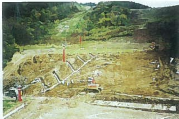
ふれあいユートピア公園パーク ゴルフ場整備工事(仁木町発注)
