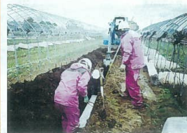
共和町下梨地区暗渠試験工事2
